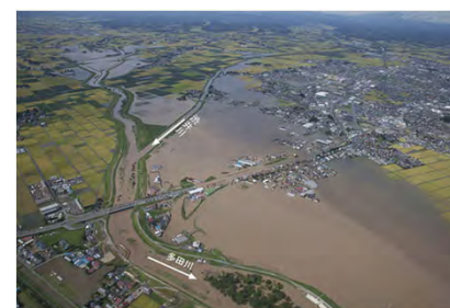
合流部での浸水状況
