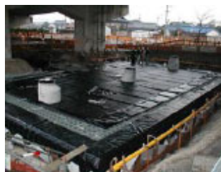
雨水貯留施設の整備 (大治町)
