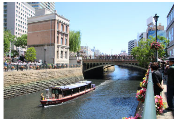
水辺空間の利活用【堀川納屋橋】 (名古屋市)
