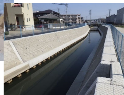
堤防整備(一宮市(準)千間堀川)
