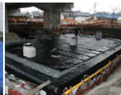
雨水貯留施設の整備 (大治町)
