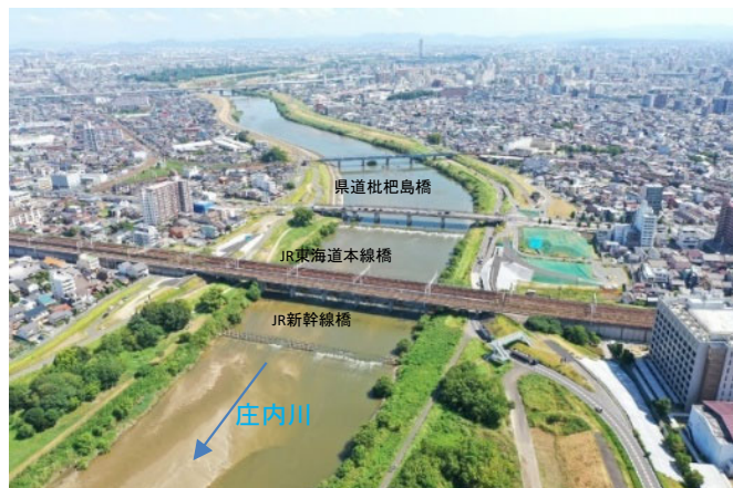
橋梁改築—狭窄部対策(庄内川河川事務所)
