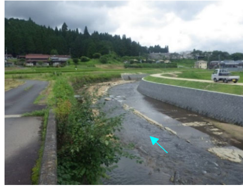
河川整備の状況（河道掘削・堤防整備）【小里川】
