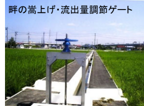
畔の高上げ・流出量調節ゲート
