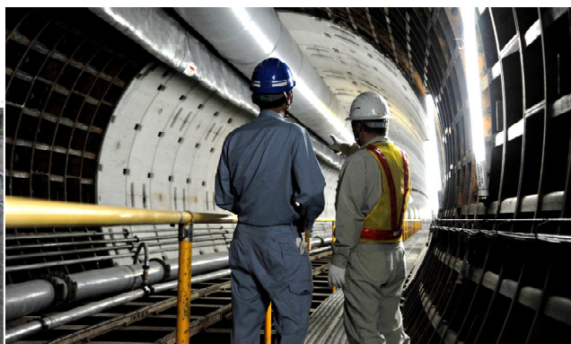
雨水貯留管の整備
