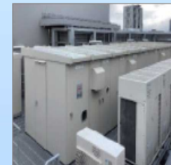
電気設備の設置場所の嵩上げ
