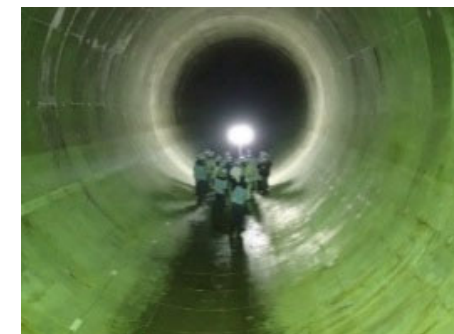
雨水貯留管の整備
