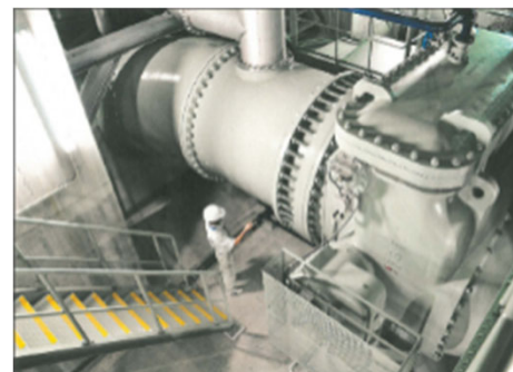
雨水ポンプの整備
