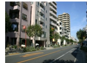
沿道建築物の不燃化
