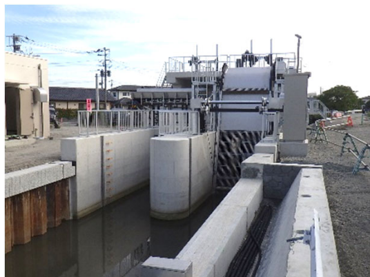
雨水ポンプ場の整備
