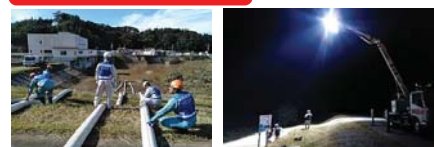
R1.10 阿武隈川での排水作業及び照明点灯（宮城県）
