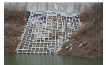
法面崩壊対策後
