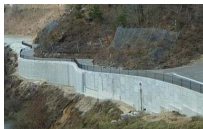
工事用道路整備後
