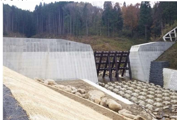
かじがいら 鍛冶ヶ入第5砂防堰堤（土岐市）
