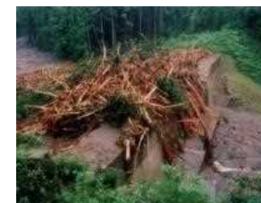
流木捕捉式治山ダム
