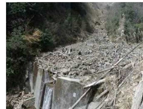
治山ダムが山腹崩壊と土砂流出を軽減した事例【大分県日田市】
