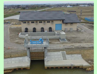
排水機場全景
