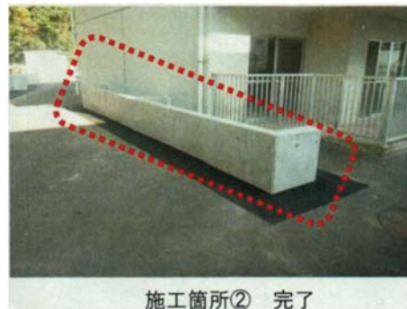
施工箇所② 完了
