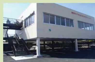
浸水を想定したピロティ形式の防災センター【豊橋市】
