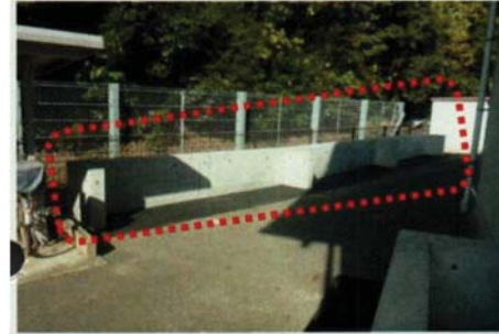
施工箇所① 完了
