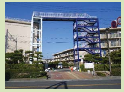
既存施設（市営住宅）へ避難階段設置【藤沢市】 その他、民間施設への補助事例あり (屋上部避難場所設置)
