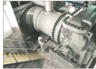
雨水ポンプの整備
