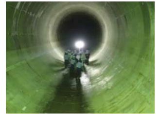
雨水貯留管の整備
