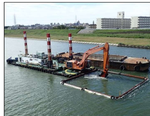
河道掘削の施工イメージ
