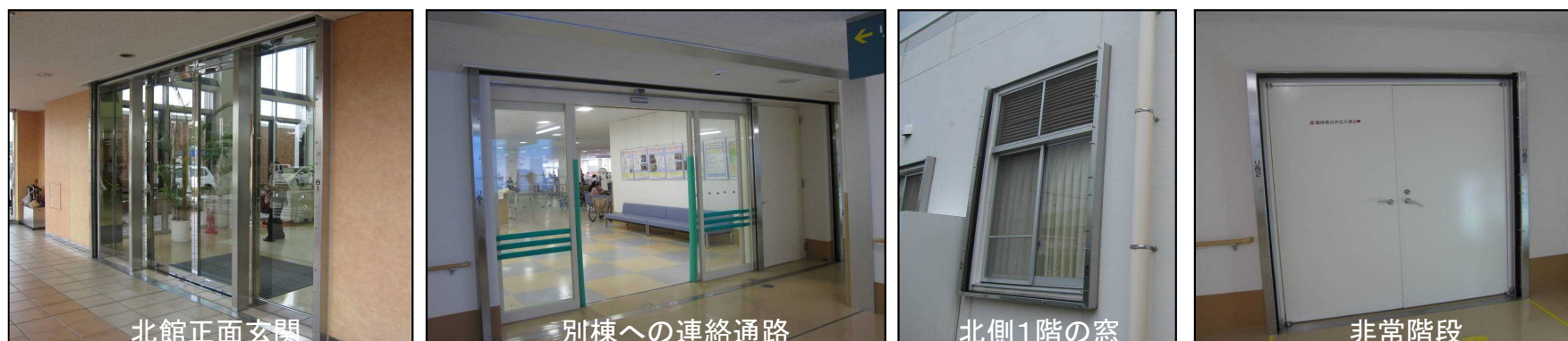
止水板のための角落しとの設置
