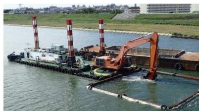
川の中の土砂をとる工事
