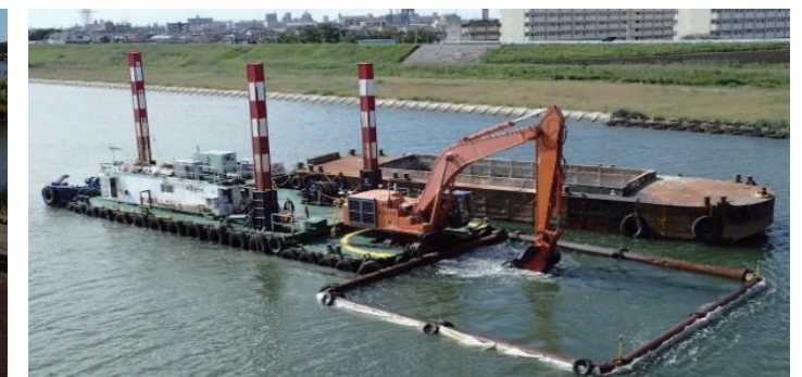
川の中の土砂をとる工事
