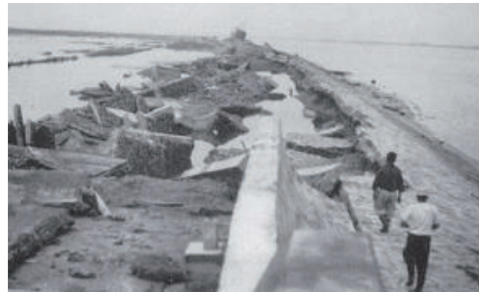
半田武豊海岸堤防の被害の様子 出典：内閣府 災害教訓の継承に関する専門調査会 ＜広報「ぼうさい」＞第20回 ( https://www.bousai.go.jp/kyoiku/kyokun/kyoukunnokeishou/pdf/bs0809.pdf )
