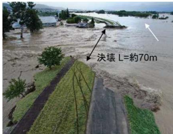
堤防の決壊状況
