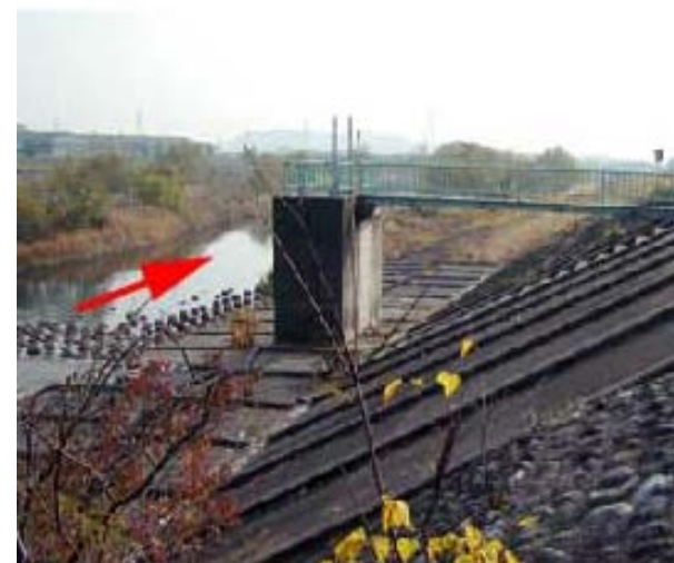
堤防の損傷なし
