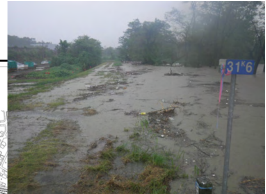
庄内川左岸31. 6k付近
