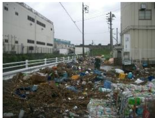
③工場群の浸水状況
