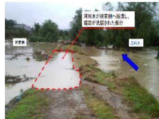
②越水による堤防洗掘
