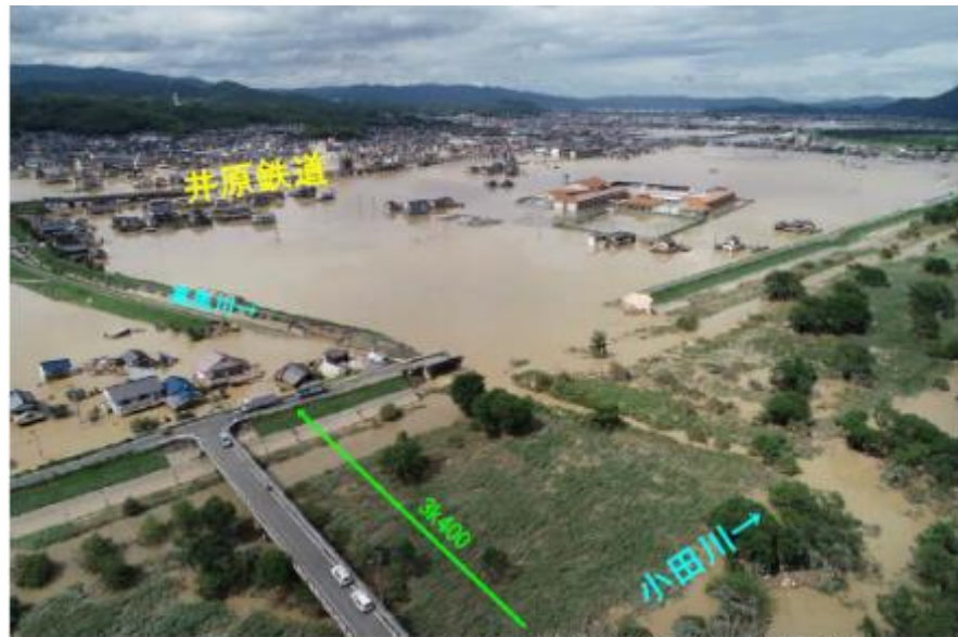
7月8日(日)撮影 左岸3k400付近堤内地
