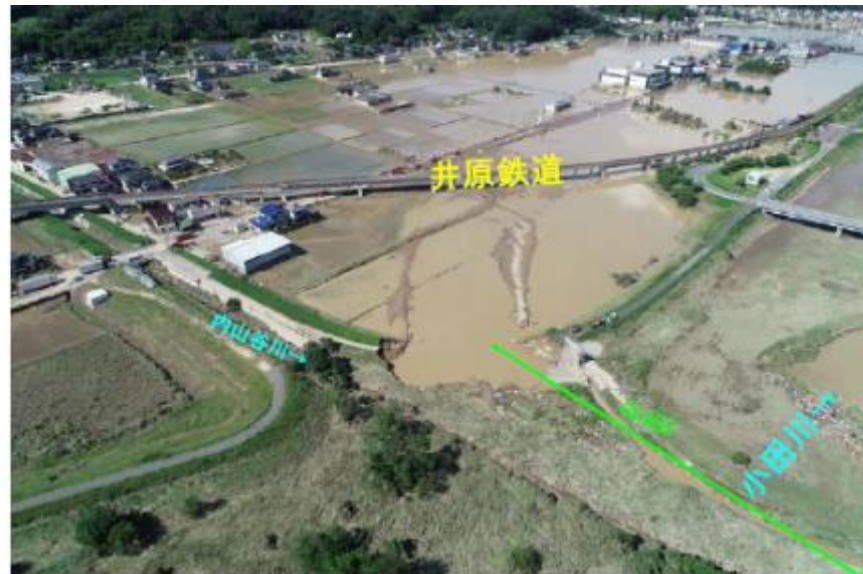
7月8日(日)撮影 左岸6k400付近堤内地
