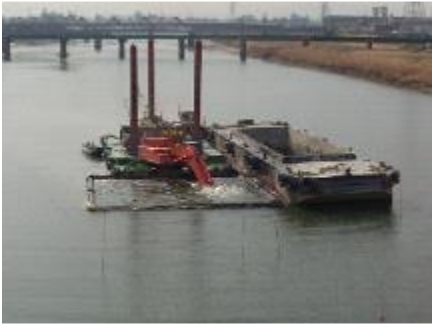
①河道掘削(台船掘削)
