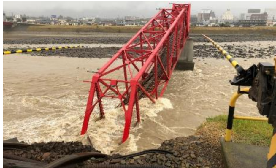
上田電鉄別所線(千曲川橋梁)
