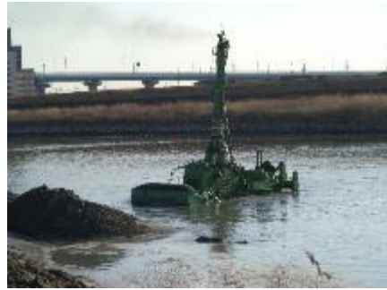
②河道掘削(水中ブル)
