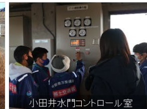
小田井水門コントロール室 コントロール室で実際に水門を操作
