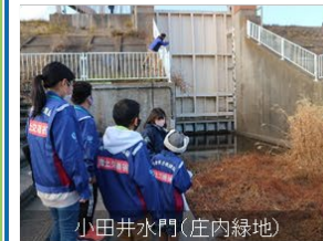
小田井水門(庄内緑地) 小田井水門に到着、状況を確認
