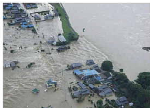
奥羽川の氾濫 平成27年9月関東・東北豪雨災害(茨城県常陸市) 写真提供:国土交通省関東地方整備局
