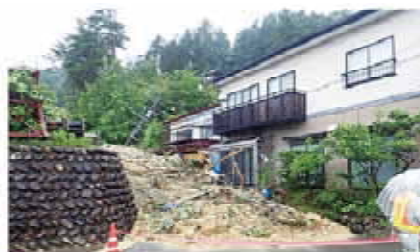
山王岡での土石流 平成30年7月豪雨災害（岐阜県高山市）
