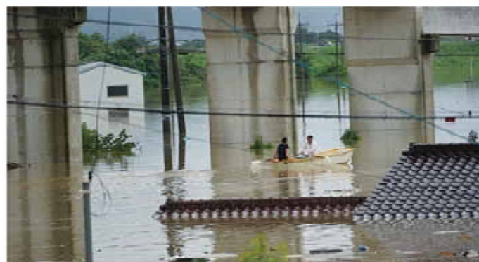
平成30年7月豪雨災害(岡山県倉敷市真庭地区) 写真提供:岡山県
