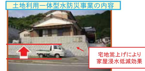
霞堤からの流水により浸水しているが宅地嵩上げにより家屋浸水は大幅に低減!
