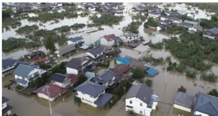
住宅等浸水状況(長野県長野市)
