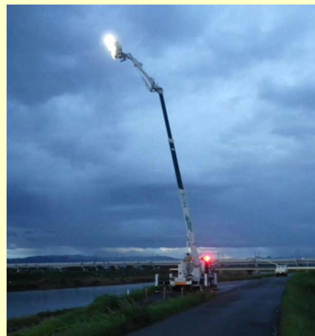
九州北部豪雨の矢部川左岸13K付近（平成24年7月）
