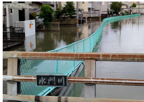
八島町の浸水被害 水門川からの越水
