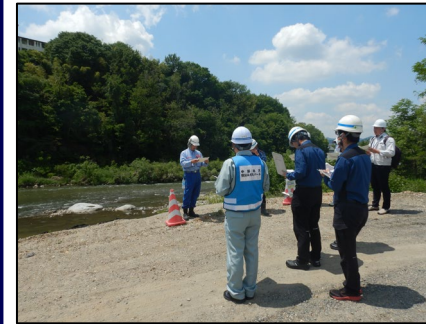
土岐川50.2k付近を巡視
