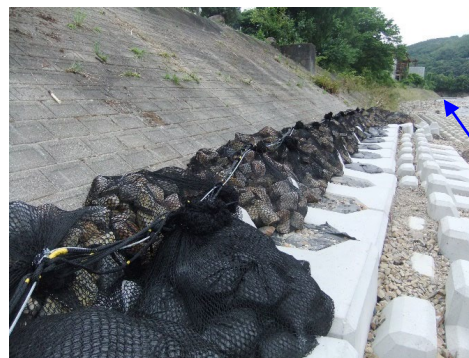
小型土のうの上に袋詰め玉石設置状況
