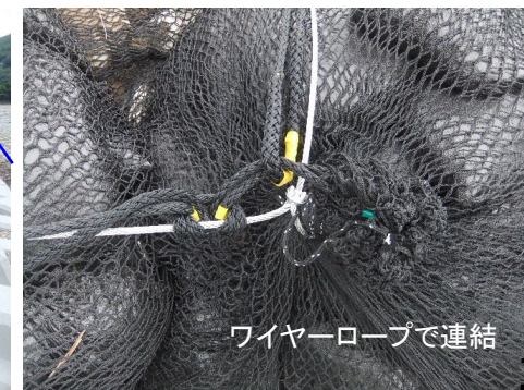
小型土のうの上に袋詰め玉石設置状況
