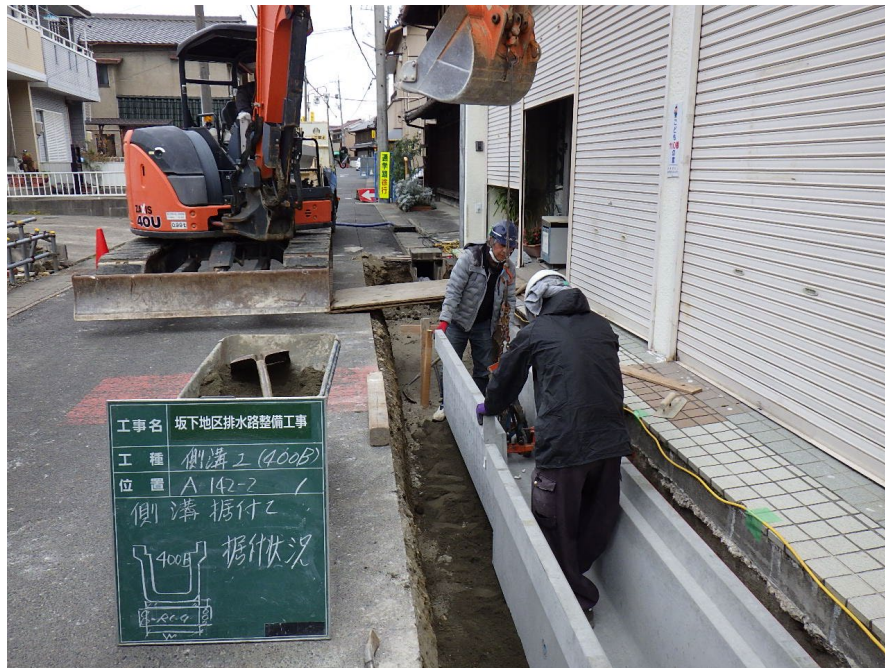
令和5年度工事実施状況
