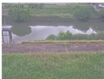
新川・電車川排水機場
