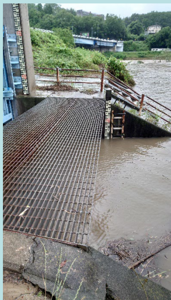
監視カメラの設置が必要な箇所のイメージ
