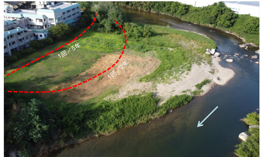
整備対象地区（R3.8撮影）
