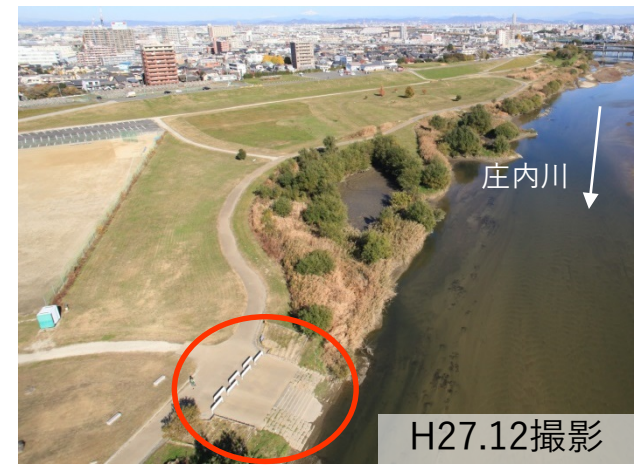
階段護岸の整備状況
