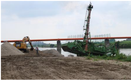
河道掘削（庄内川河川事務所）
