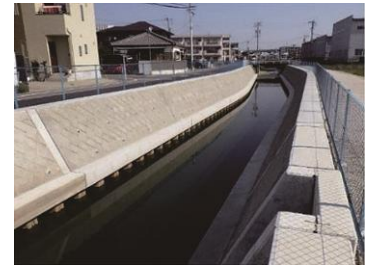
堤防整備（一宮市（準）千間堀川）
