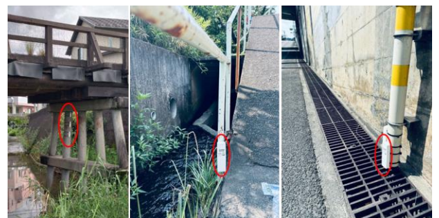
陸橋付近の橋脚
