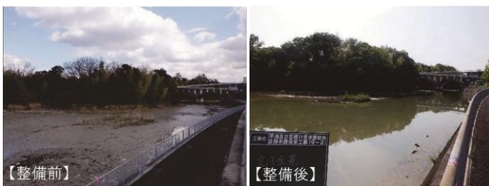
河川・ため池・調整池の堆積土砂の浚渫（名古屋市）
