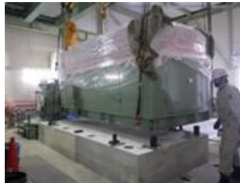
雨水ポンプ場の機能強化（清須市）
