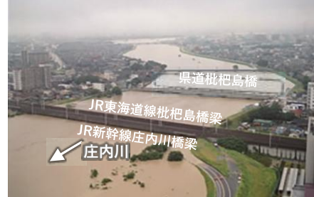
【特定構造物改築事業】引堤及び橋梁の架け替え
