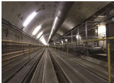
貯留管等の整備（名古屋市）
