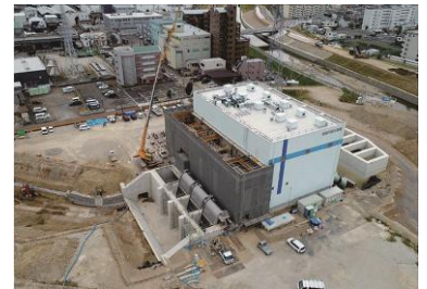
地蔵川排水機場の整備（愛知県）
