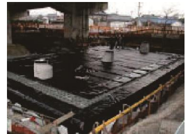
雨水貯留施設の整備（大治町）
