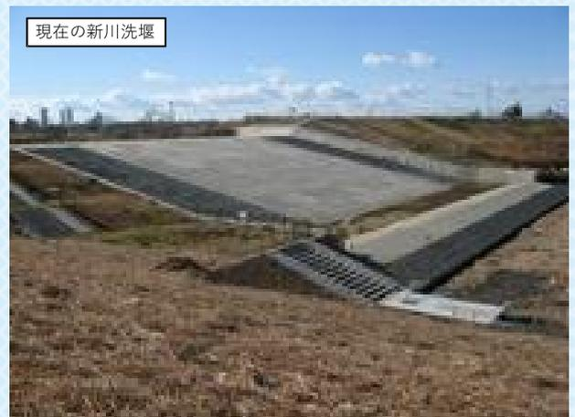
河口付近一帯の干拓が実施された後、庄内川では洪水が頻発していました。その対策として、河川の流量配分を変える大規模な工事（新たな河川の開削、新川洗堰の築造）が実施されてきました。
