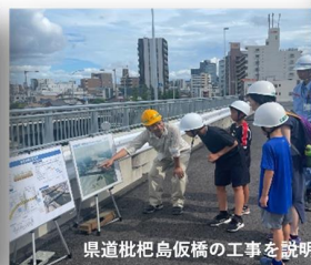
県道枇杷島仮橋の工事を説明
