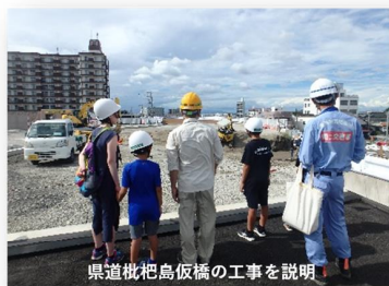
県道枇杷島仮橋の工事を説明
