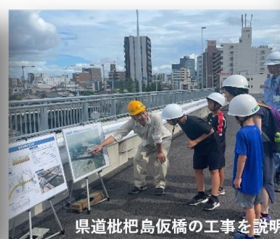
県道枇杷島仮橋の工事を説明
