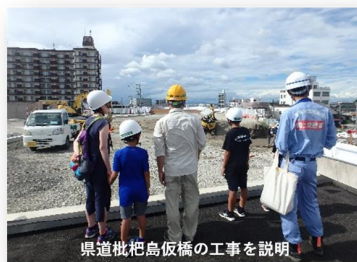
県道枇杷島仮橋の工事を説明
