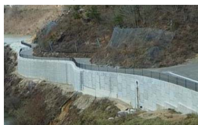
工事用道路整備後
