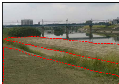
河道内の樹木伐採(施工後)
