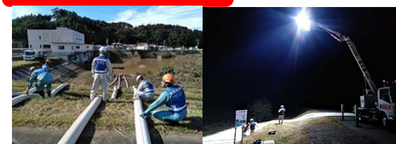
阿武隈川で排水作業(宮城県) 阿武隈川で照明点灯(宮城県)
