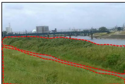
河道内の樹木伐採(施工前)
