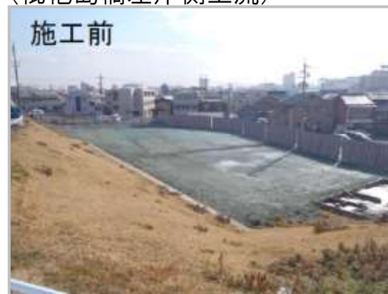
平成29年度工事実施箇所の状況 (枇杷島橋左岸側上流)
