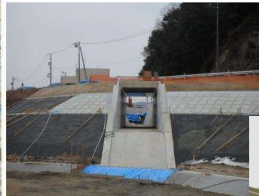
支川脇之島川合流点整備状況 (吐出口)
