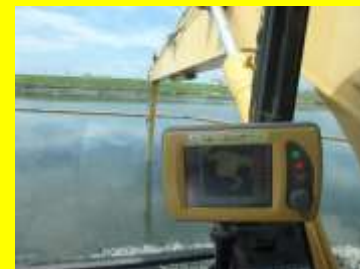
マシンガイダンスによるバックホウ施工状況
