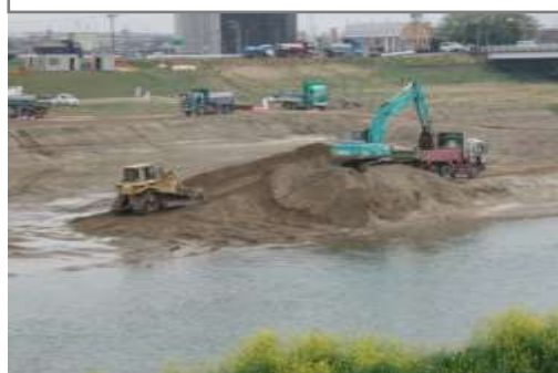
局所的に堆積した土砂の撤去
