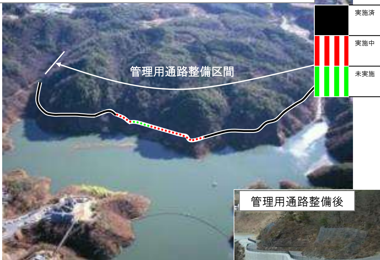
管理用通路整備（貯水池の法面の崩壊対策）
