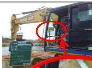
ICTバックホウによる法面整形
