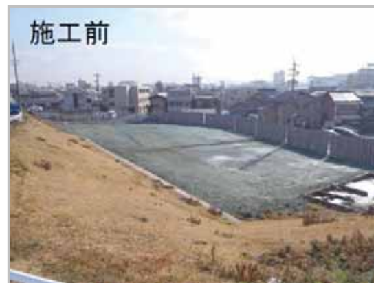
平成27年度工事実施箇所の状況
