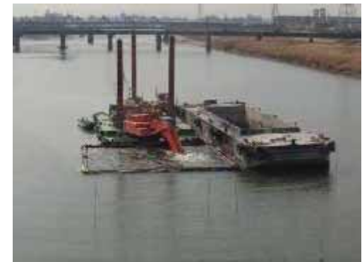
しゅんせつの施工イメージ
