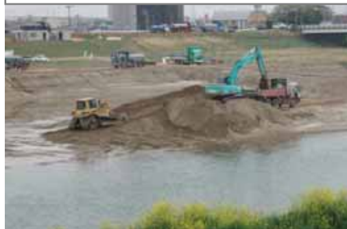
局所的に堆積した土砂の撤去
