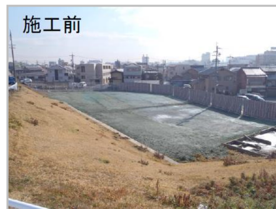
平成27年度工事実施箇所の状況
