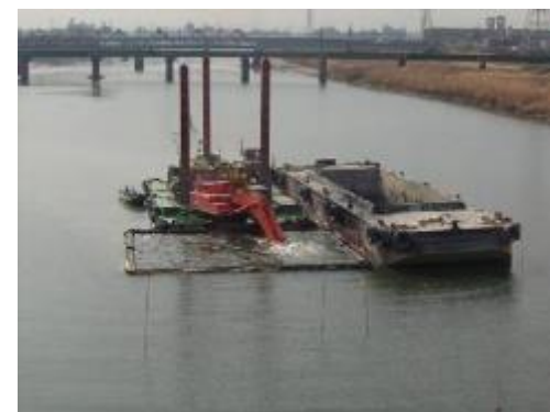
しゅんせつの施工イメージ
