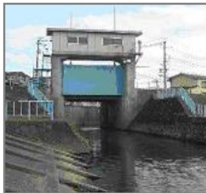
守山排水樋門
