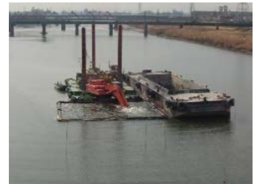
しゅんせつの施工イメージ
