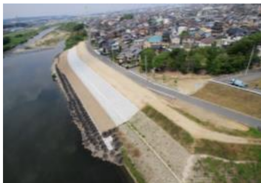
平成24年度 庄内川大留護岸工事(平成25年6月完成)
