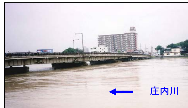
東海豪雨時の出水状況（県道枇杷島橋）
