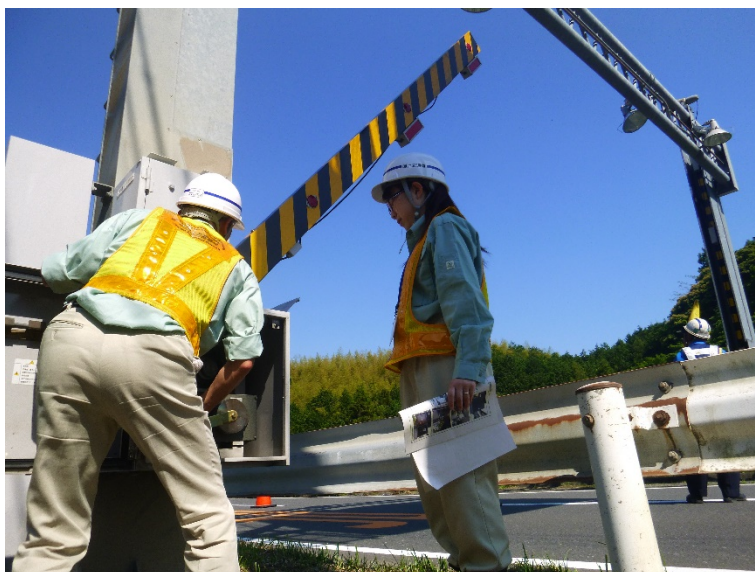
停電を想定した手動による遮断機降下
