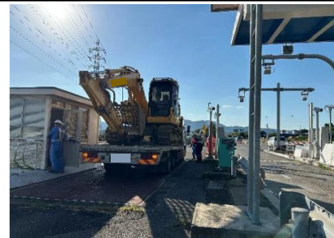
中日本高速道路株式会社 名古屋支社（説明状況）
