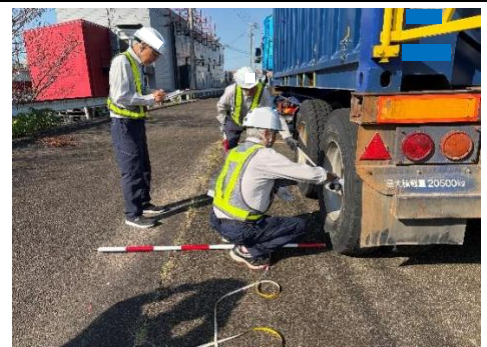
三重河川国道事務所（計測状況）
