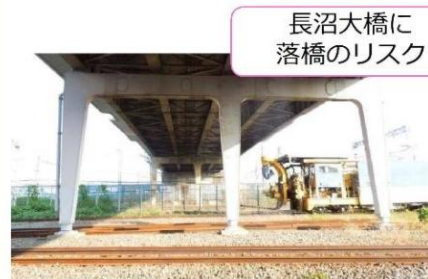
▲長沼大橋のロッキング橋脚
