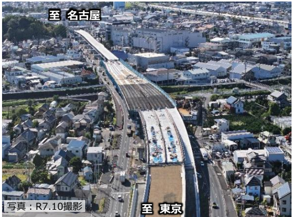
【尾羽第 2 高架橋付近】
