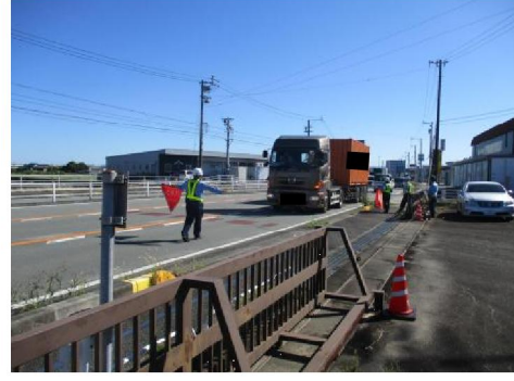
三重河川国道事務所（誘導状況）
