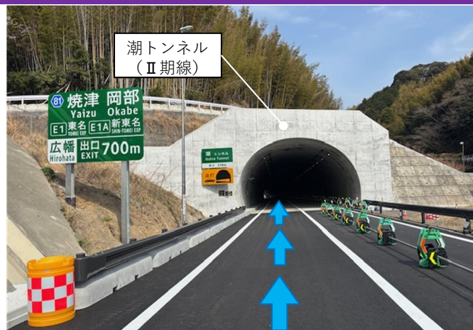
潮トンネルⅡ期線 西坑口（上り線）
