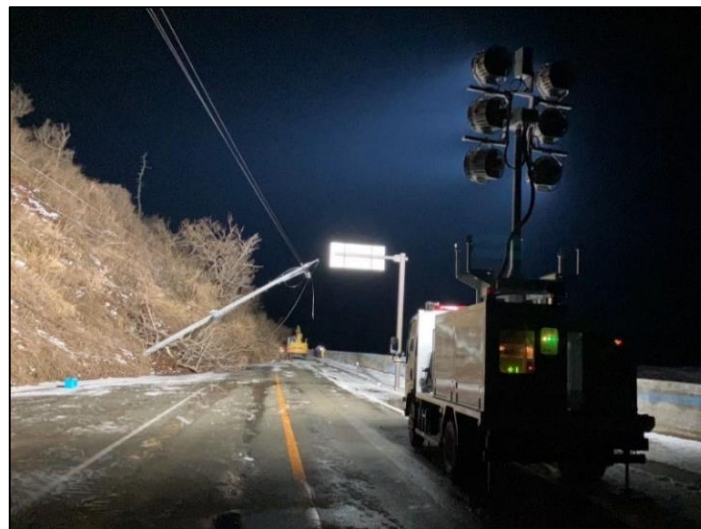
4工区(輪島市野田町)で活動する照明車(1/8)
