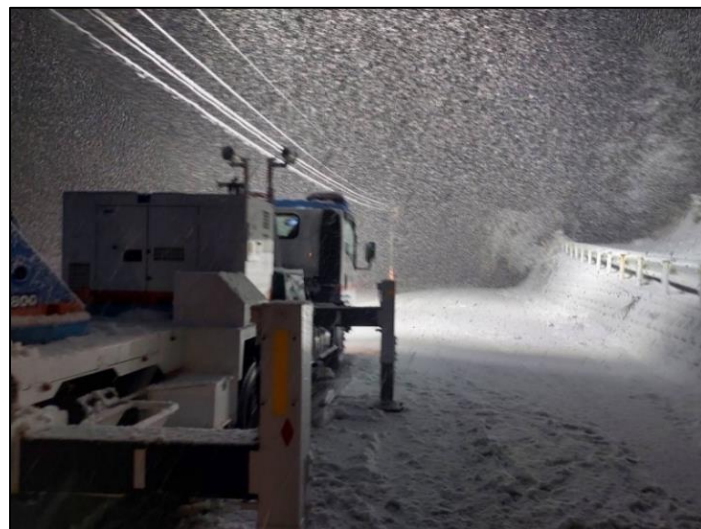
6工区(珠洲市若山町)で活動する照明車(1/7)
