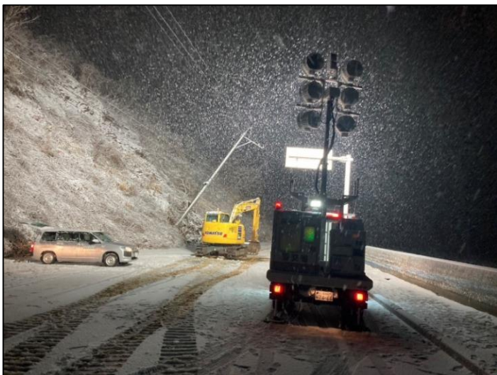
4工区(輪島市野田町)で活動する照明車(1/7)
