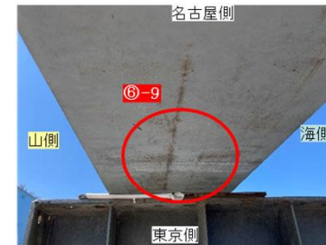
山側セッティングビーム下面 接触痕
