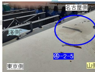
海側セッティングビーム下面 接触痕
