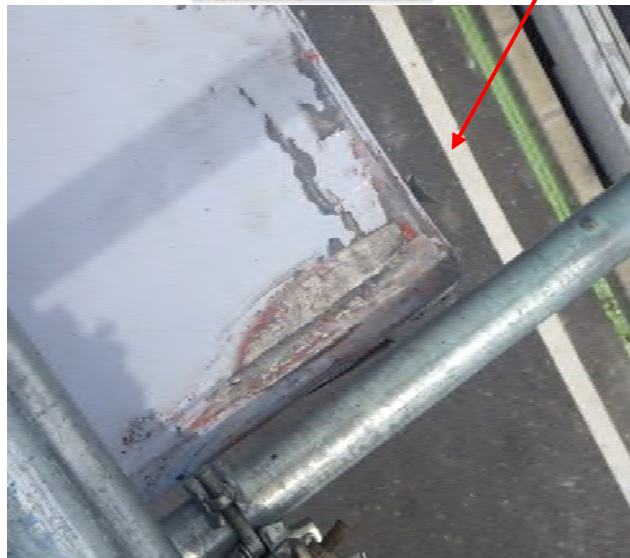
名古屋側の橋脚角
