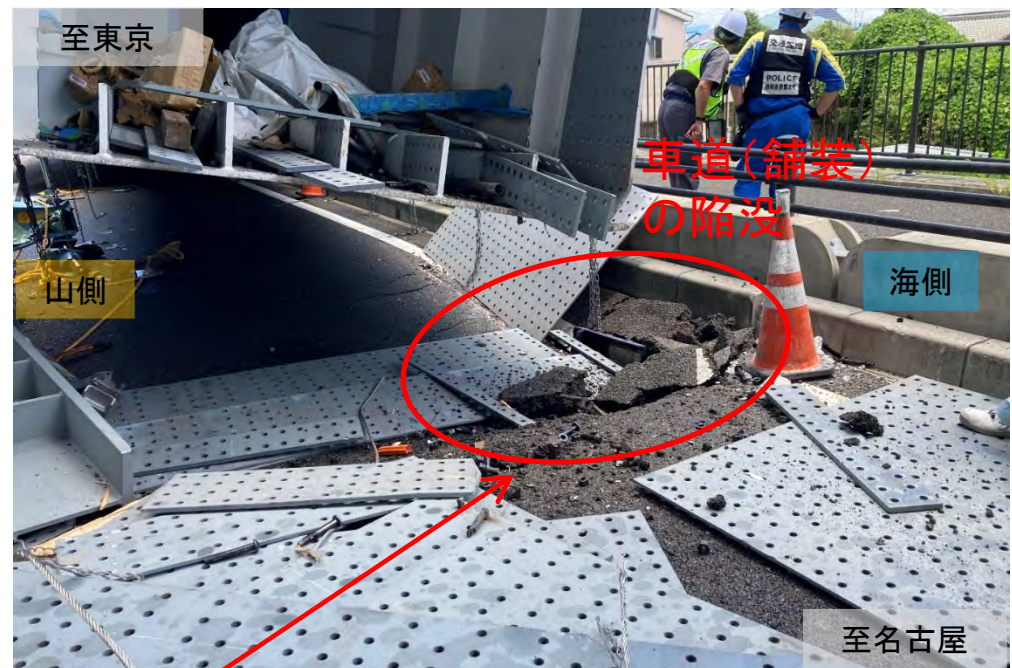
P4橋脚付近
