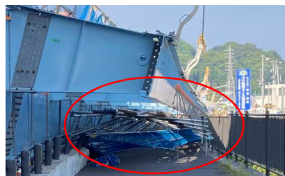
付属物撤去（吊り足場等）
