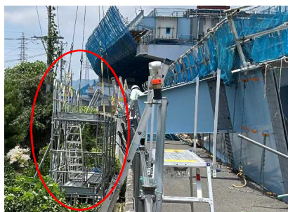
橋桁分割のための仮設足場
