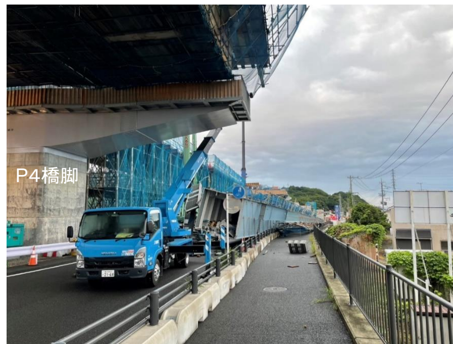
○終点から起点を望む
