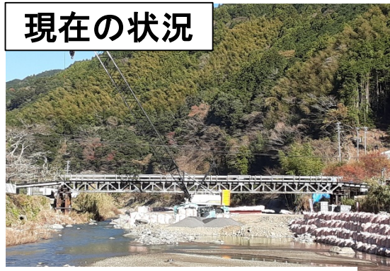
応急組立橋上部工施工中(R4.12.20時点)
